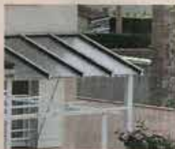
Le polycarbonate est l'une des couvertures les plus courantes pour les pergolas.
